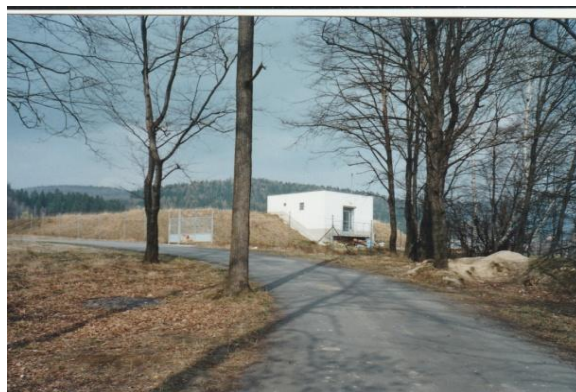
Obr. 5 Vodojem 3000 m3 nad závodem
